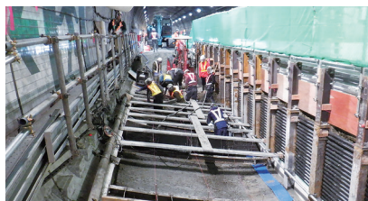
トンネルインバート打設工事(例)
