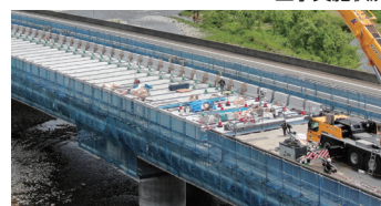
工事実施状況
