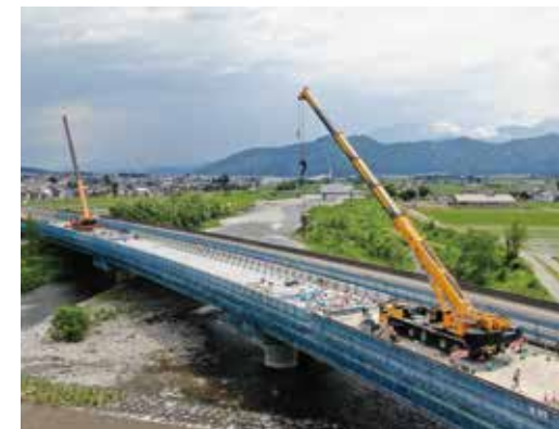
工事実施状況
