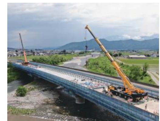
工事実施状況
