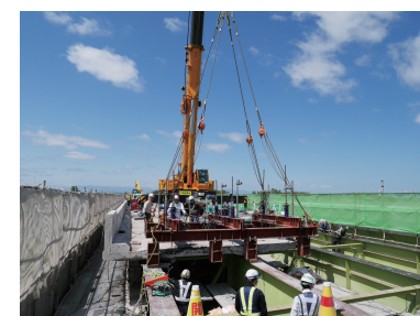
古い床版撤去状況
