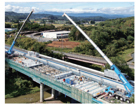
工事実施状況
