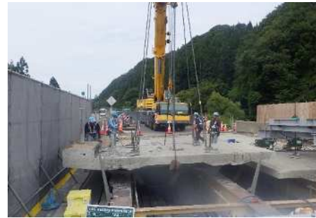
【既設コンクリート床版撤去】
