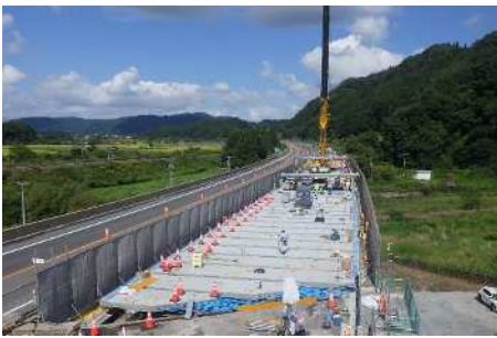
【新規コンクリート床版設置】
