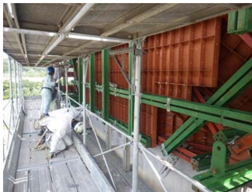
型枠工（側枠）
