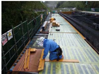
張出床版型枠設置
