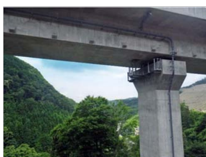
排水管（桁外）
