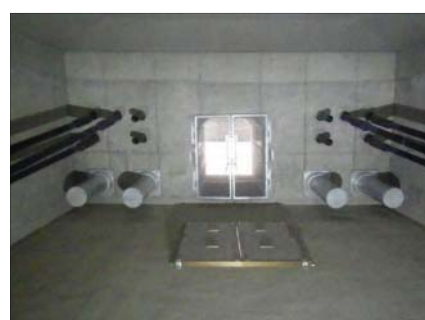
落橋防止構造 桁側
