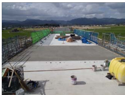
上床版コンクリート打設
