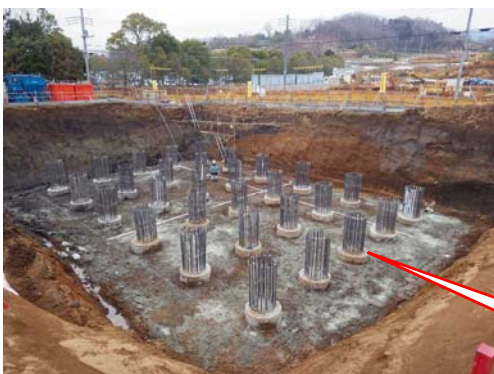
場所打ち杭 (杭頭処理後)
