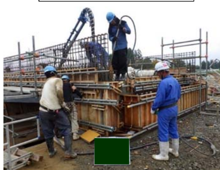
コンクリート打設
