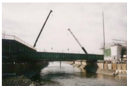
梁(架設桁)架設状況
