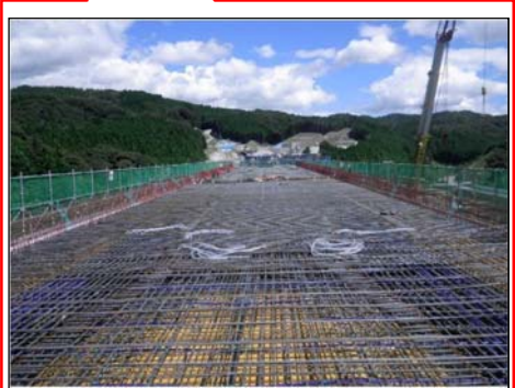
鉄筋組立完了
