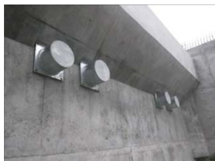
落橋防止構造 橋台側
