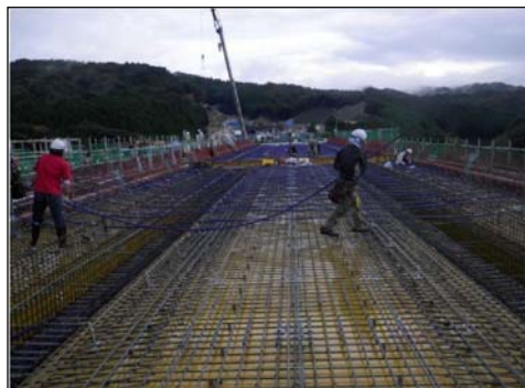
床版横締めケーブル配置状況
