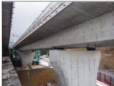
支保工撤去完了(参考例)
