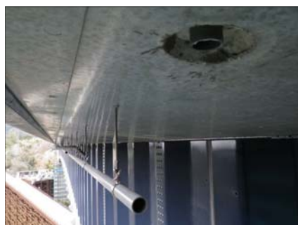
排水管（桁外）
