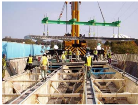
調整工（高さ調整ボルトによる）
