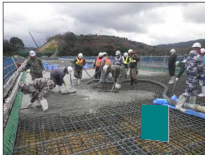
コンクリート打設
