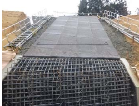
コンクリート打設
