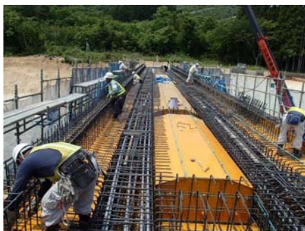
鉄筋組立作業状況
