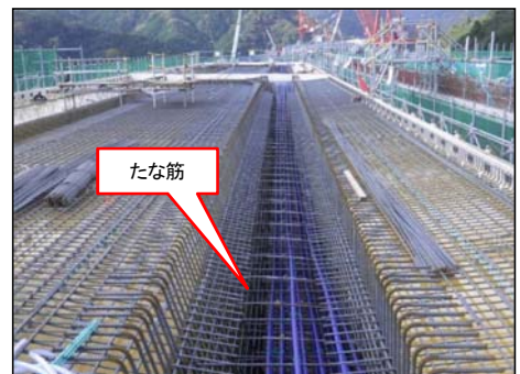
縦締めケーブル配置完了
