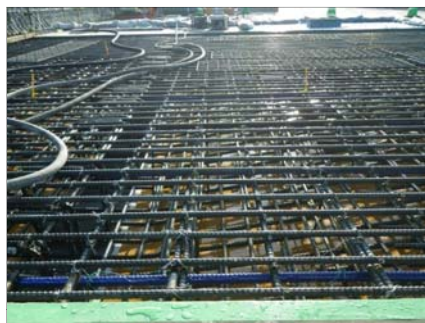
上床版コンクリート打設
