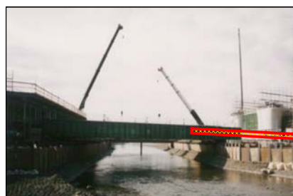
梁（架設桁）架設状況
