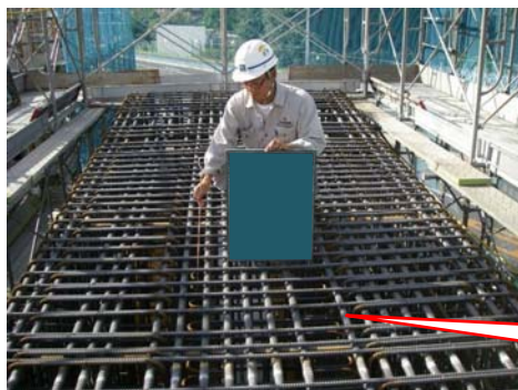
支承アンカー用の箱抜きを設置するために、鉄筋をずらして配置する。
