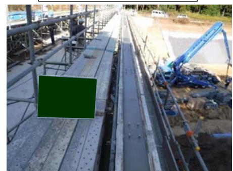
コンクリート打設(壁高欄)
