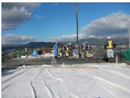
上床版コンクリート打設
