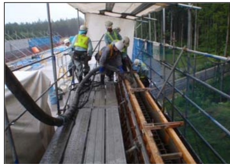
壁高欄コンクリート打設
