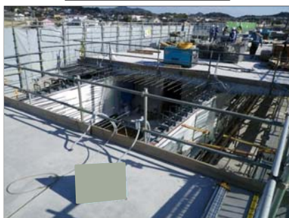
波形鋼板架設
