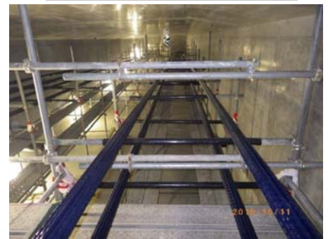
外ケーブル施工完了
