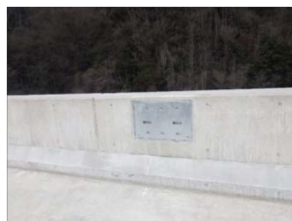
落橋防止構造 桁側
