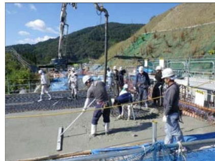
上床版コンクリート打設
