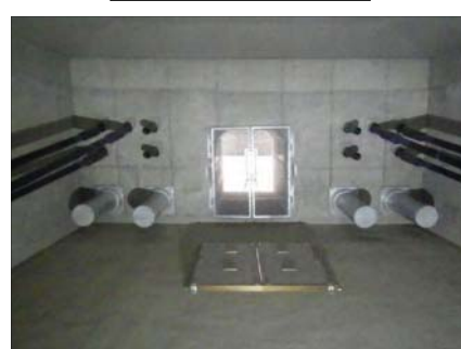
落橋防止構造 桁側
