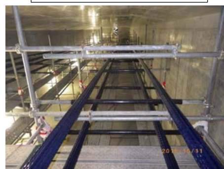
外ケーブル施工完了
