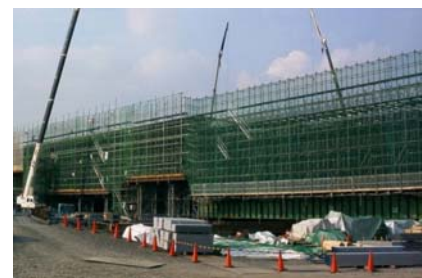
梁(架設桁)+くさび結合式支保工
