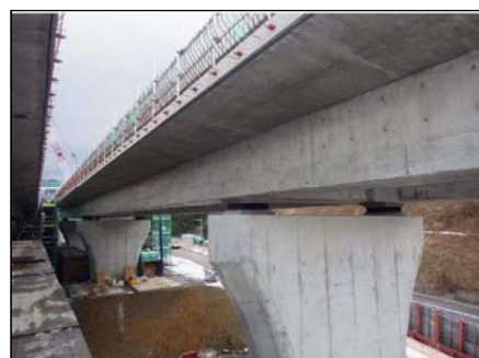
型枠支保工撤去完了
