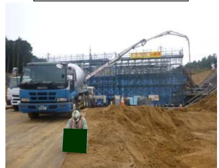
コンクリート打設
