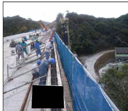
壁 高 欄 の 施 工
