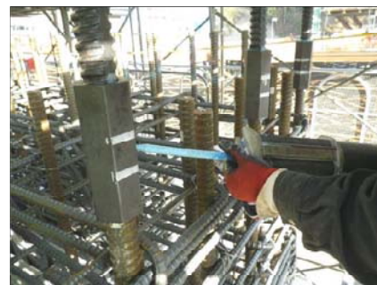
鉄筋継ぎ手
