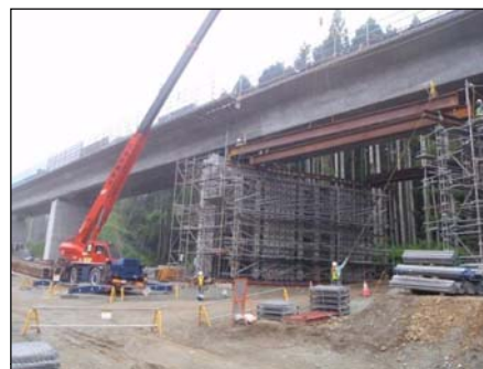
型枠支保工撤去完了
