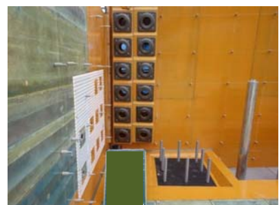
緊張端付近の型枠状況
