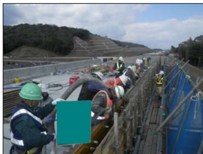
コンクリート打設
