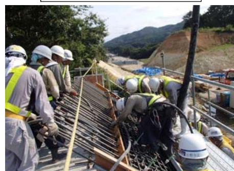
コンクリート打設
