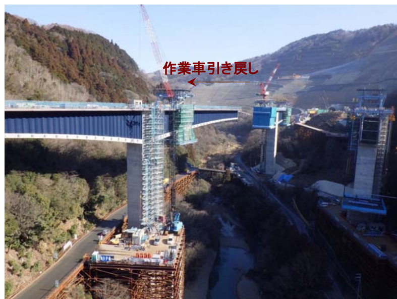
移動作業車後退・解体
