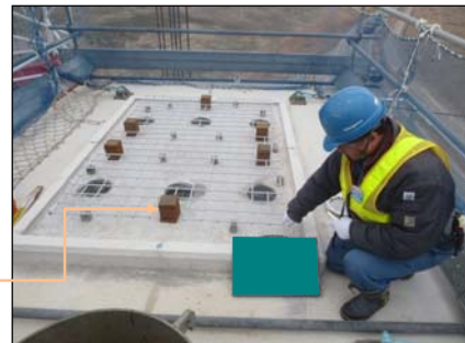
沓座鉄筋設置
