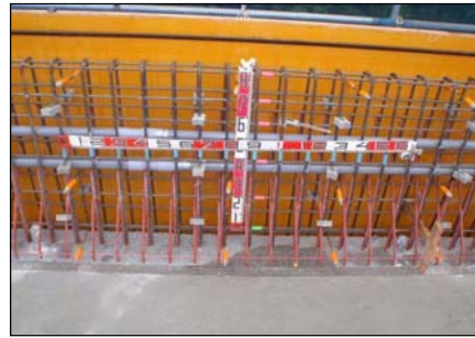
壁高欄コンクリート打設
