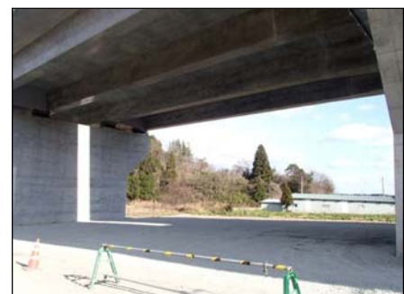
型枠支保工撤去完了
