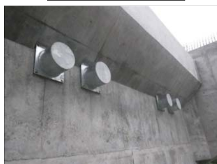
落橋防止構造 橋台側
