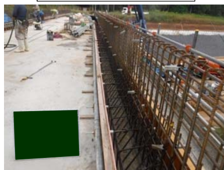
コンクリート打設(地覆)
