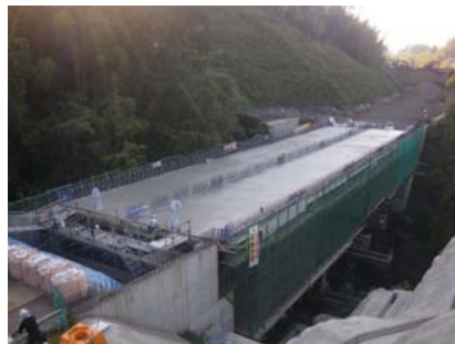
コンクリート打設完了
