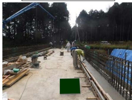
コンクリート打設(地覆)
