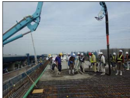
コンクリート打設
