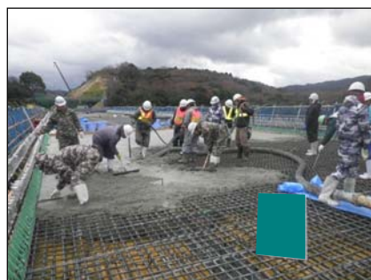
コンクリート打設
