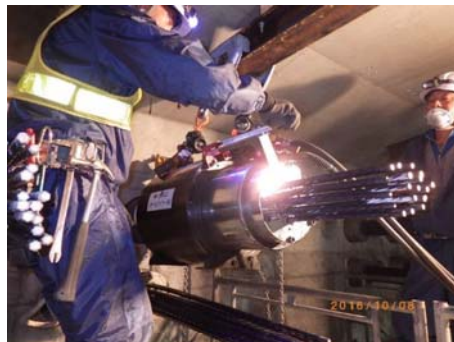
外ケーブル施工完了
