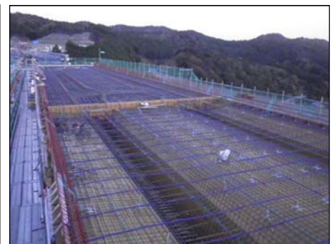
床版横締めケーブル配置完了
