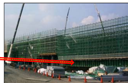
梁（架設桁）+くさび結合式支保工
