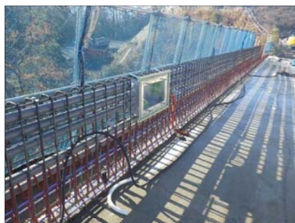
落橋防止構造 橋台側
