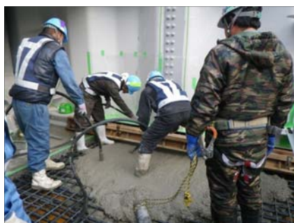
下床版コンクリート打設
