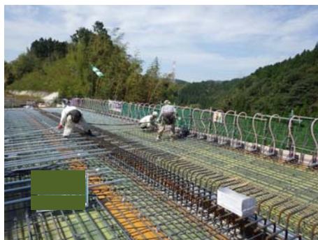
鉄筋・横締め設置状況
