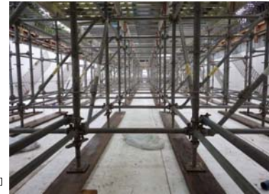
床版型枠設置完了
