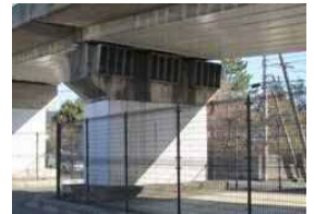
▼橋脚補強の事例
