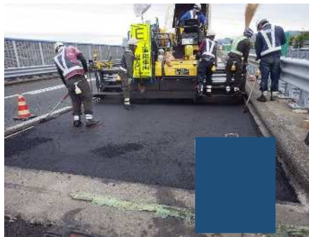
アスファルト混合物敷均し
