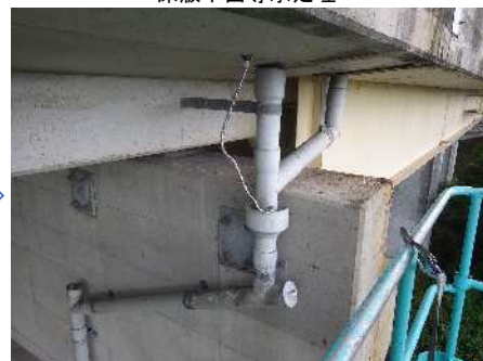
床版下面導水処理
