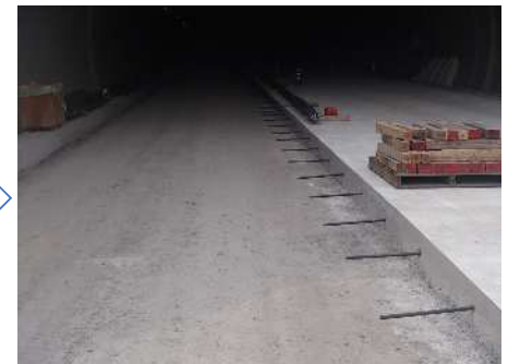
1車線分打設完了
