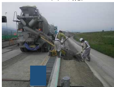
コンクリート打設
