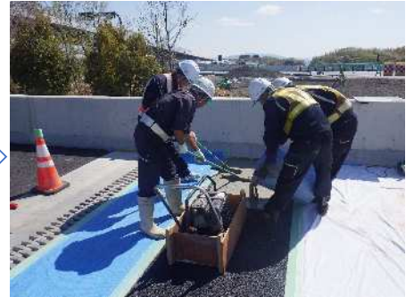
セメントミルク注入
