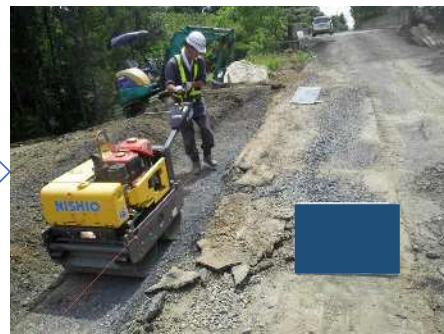
基礎材締固め
