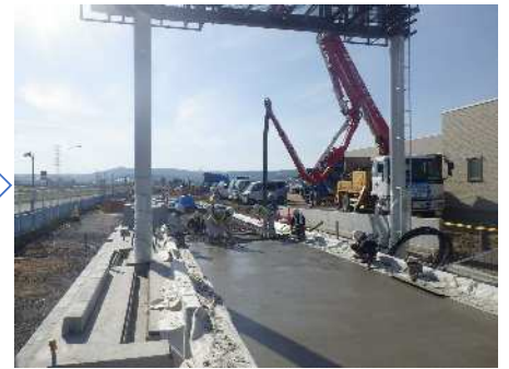
コンクリート打設
