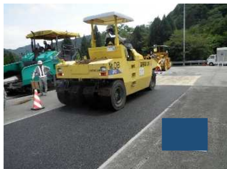
試験舗装(2次転圧)
