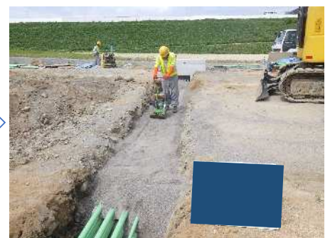
保護砂埋戻し・締固め
