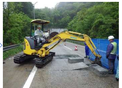
既設舗装の剥取り
