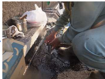
ドレーン設置
