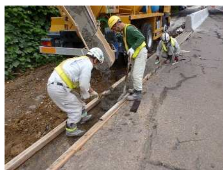
基礎コンクリート打設
