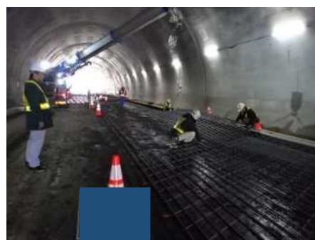
鉄筋設置状況
