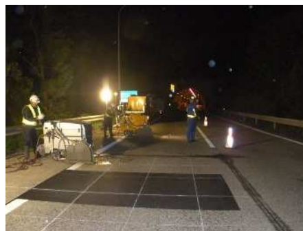
既設舗装の切断
