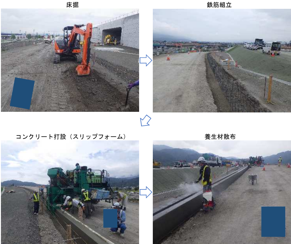
成型機は、コンクリートを供給する搬送装置、鋼製型枠及び締固め装置から構成される。
