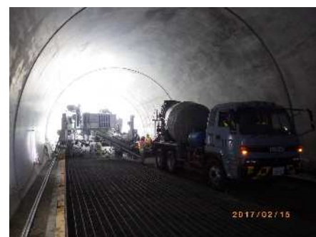
コンクリート打設
