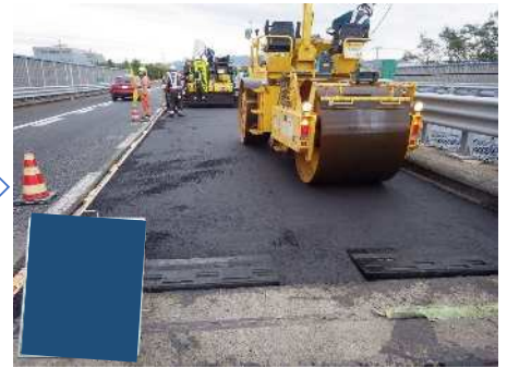
締固め（1次転圧）
