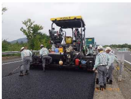
アスファルト混合物敷均し
