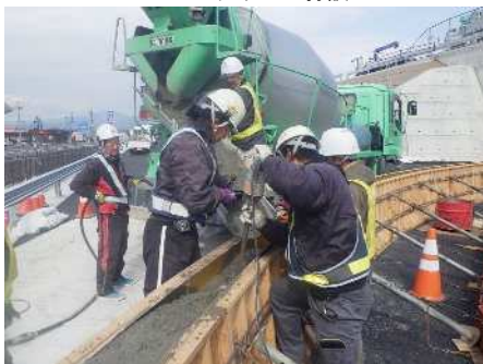
コンクリート打設
