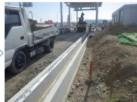
用排水溝完成
