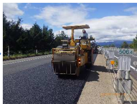
締固め（1次転圧）
