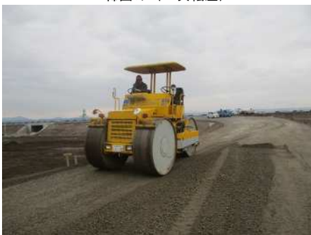
締固め（1次転圧）
