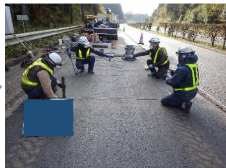
ループコイル埋設
