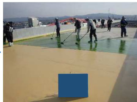
舗装用接着材塗布
