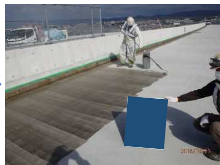
床版用接着材塗布
