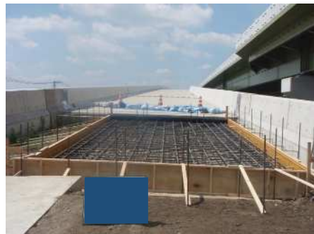
型枠設置・鉄筋工
