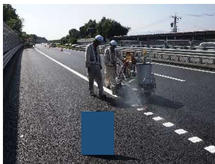
路面標示（ライン）施工
