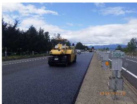
締固め（2次転圧）
