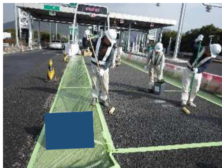
プライマー塗布
