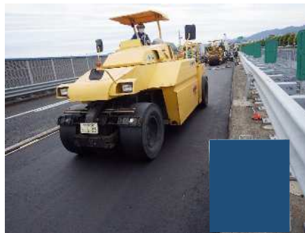
締固め（2次転圧）
