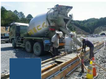
コンクリート打設
