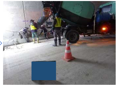
コンクリート打設
