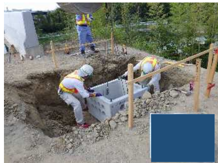
ハンドホール据付
