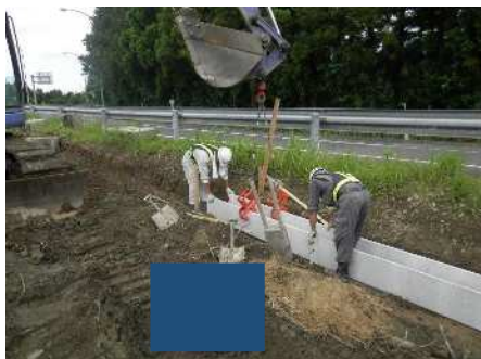
プレキャスト製品(U字溝)の据付
