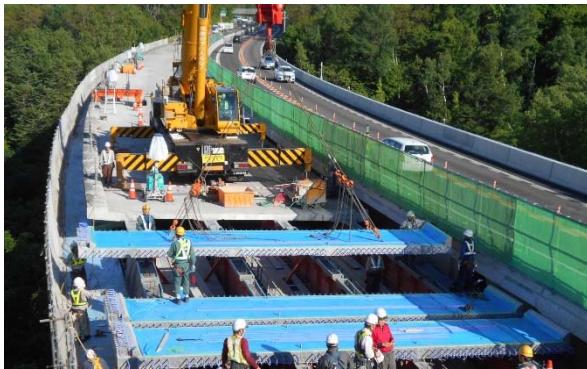
【新設床版の設置状況】
