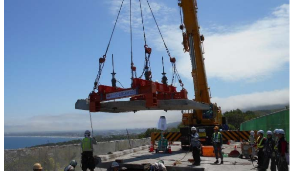
【既設床版の撤去状況】
