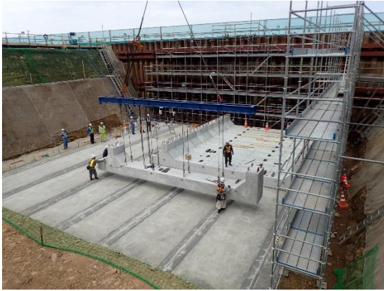
【函渠組立状況①】
