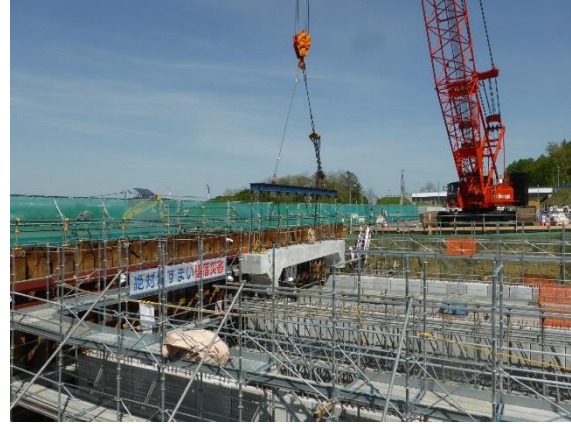
【函渠組立状況②】
