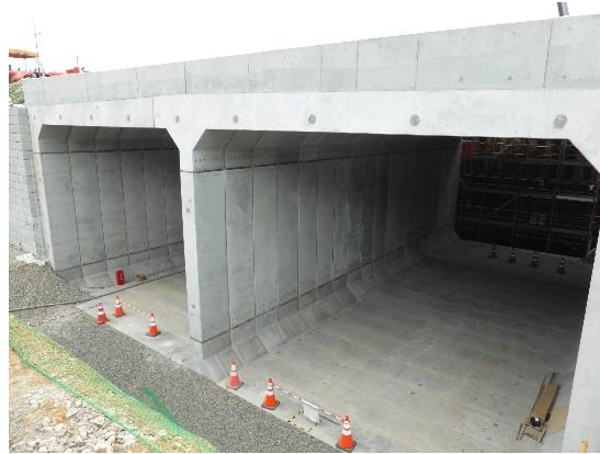
【函渠組立完了】
