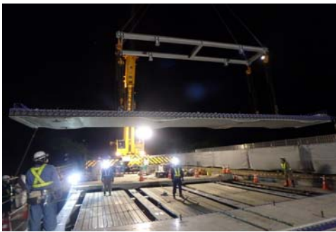
【新規コンクリート床版設置】
