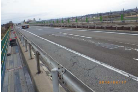
【新規コンクリート床版設置】
