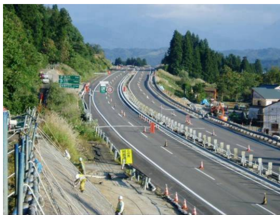
《復旧後の完成状況》
