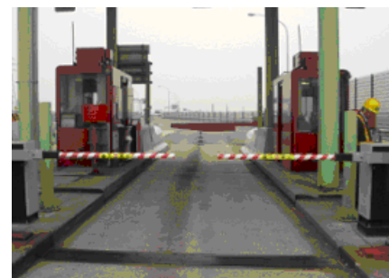
《一般レーンの開閉バー設置》
