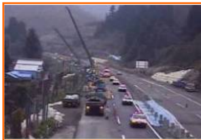
緊急車両の通行を確保しながらの災害復旧
