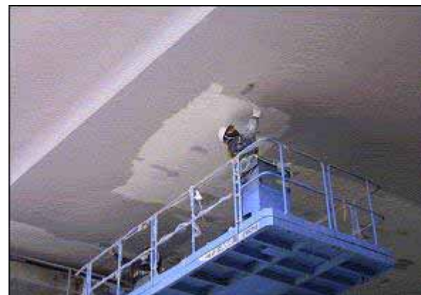
コンクリート剥落対策工事
