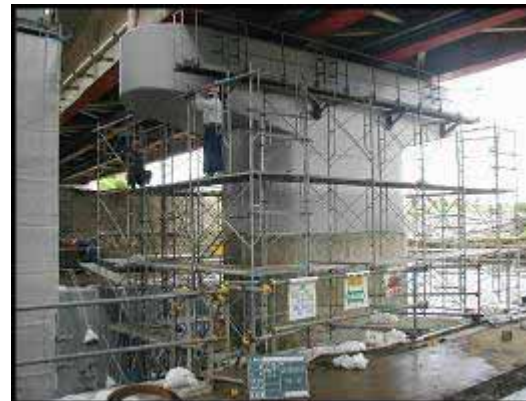
橋梁の耐震補強工事
