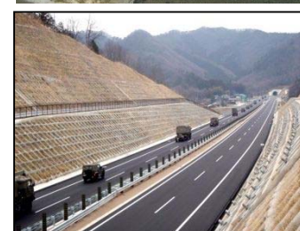
写真左上 緊急復旧の状況 発災直後では、段差やひび割れを補修し、通行できる路面確保が最重要
