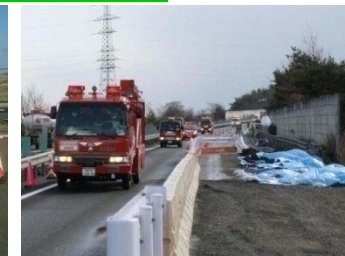
写真左上 緊急復旧の状況 発災直後では、段差やひび割れを補修し、通行できる路面確保が最重要
