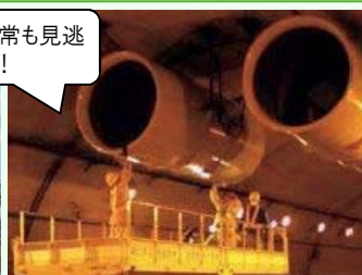
トンネル換気設備の点検
