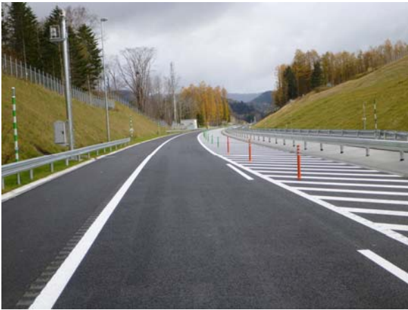
ランブルストリップス対策のイメージ (道東道の事例)
