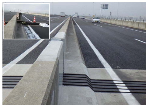
仙台東部道路 仙台IC～仙台港北IC間
