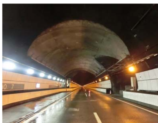
撤去後(関越道 関越トンネル)
