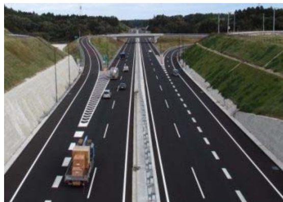
開通後の様子(茂原北 IC 付近)
