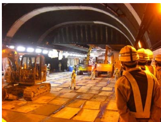
撤去の状況(関越道 関越トンネル)
