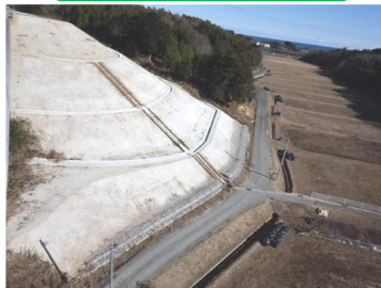
復旧状況(平成25年12月)
