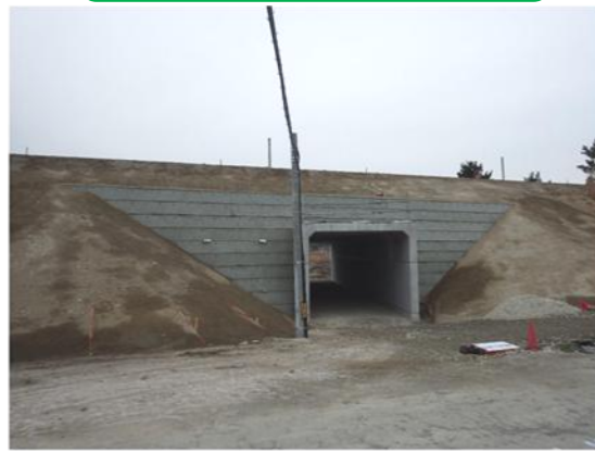
復旧状況(平成25年12月)
