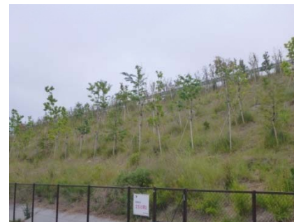
▲盛土のり面の樹林化形成
