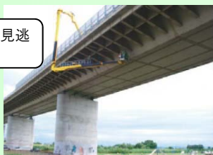
橋梁点検車による点検
