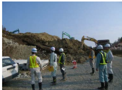
▲現場立会確認
