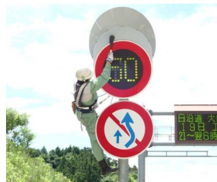
▲可変標識装置保守点検
