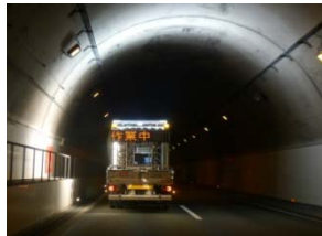
▲覆工コンクリート表面撮影 高精細デジタルビデオカメラにより高速走行で撮影し、覆工のひび割れ等を調査
