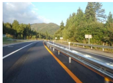
▲車線の分離(幅狭両面型ガードレール)
