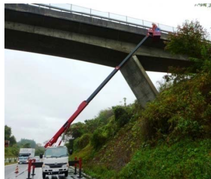
▲跨道橋(OV)点検業務
