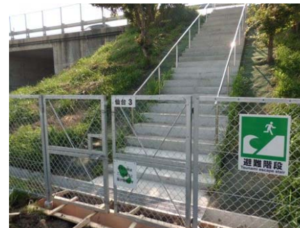
▲津波避難階段の設置事例(仙台東部道路)
