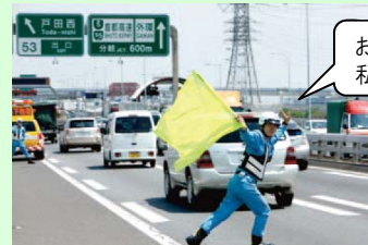
落下物の処理作業
