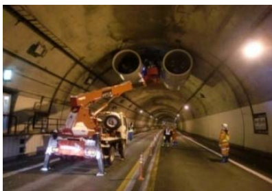
▲点検実施状況(ジェットファン)
