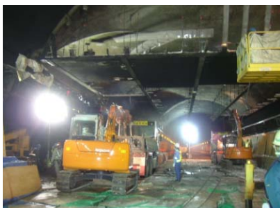
▲天井板撤去(関越トンネル)
