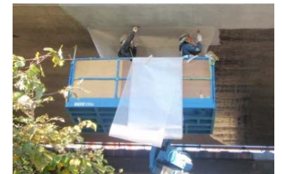
▲橋梁はく落補修
