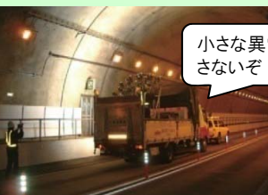
CCDカメラによるトンネル内点検
