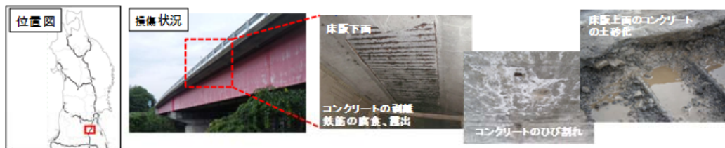
▲違反車両(軸重2t超過)がRC床版に与える影響
