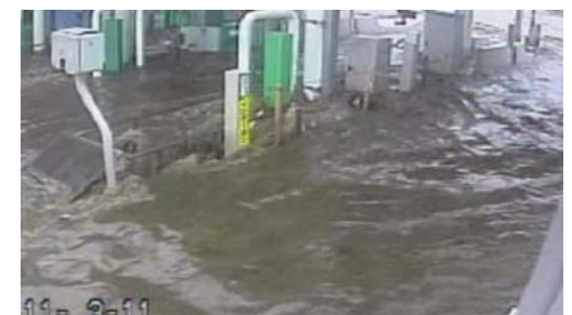
▲東日本大震災における料金所の津波被害状況
