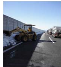
▲路肩排雪作業状況
