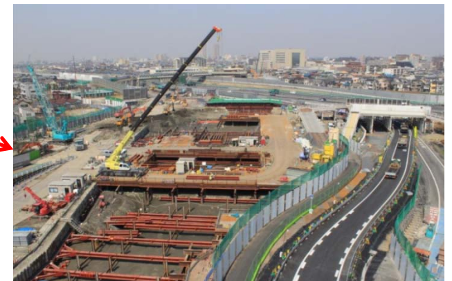
京葉ジャンクション部の施工
