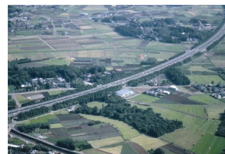
▲樹林形成された盛土のり面
