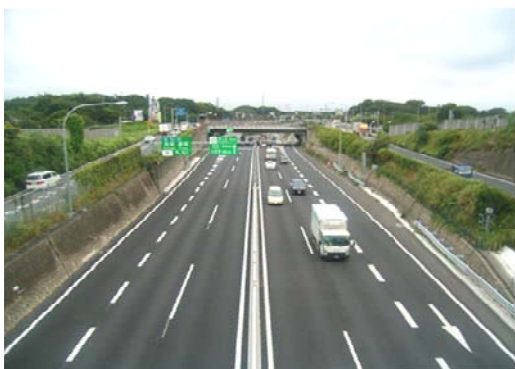
付加車線の運用状況
