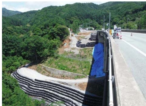
応急復旧工事状況
