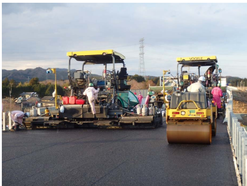
舗装工事状況
