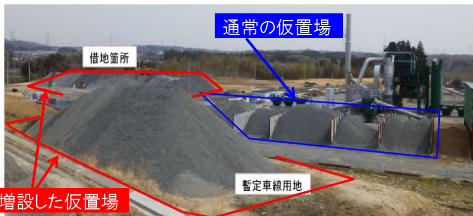
砕石仮置き場の増設
