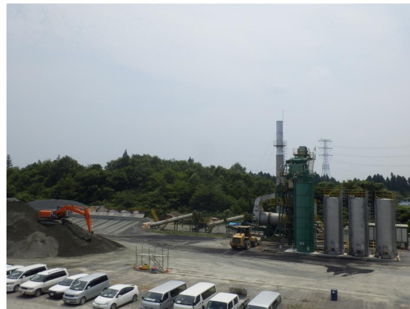
仮設アスファルトプラントの増設
