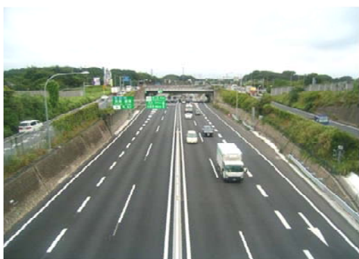
付加車線の運用状況
