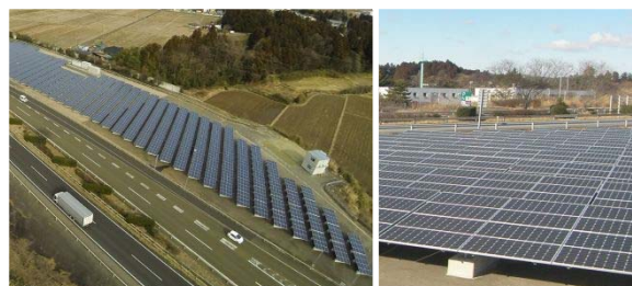
仙台泉太陽光発電所
