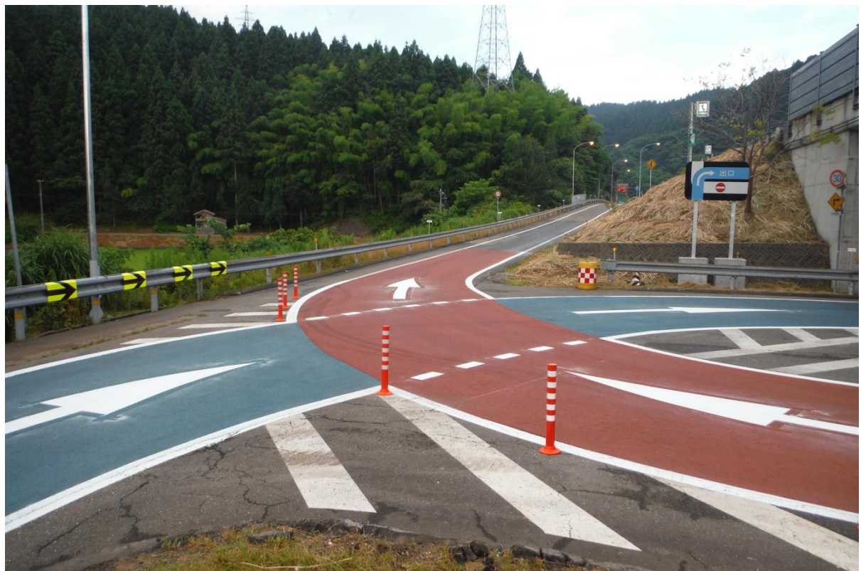
《平面Y型ICの交差点部の対策事例(北陸道 能生IC)》
