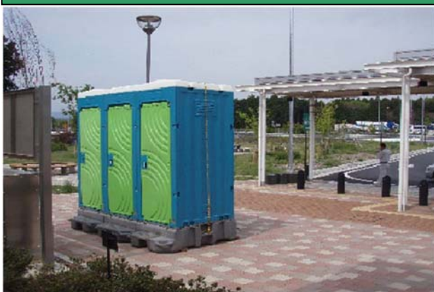
臨時トイレの設置
