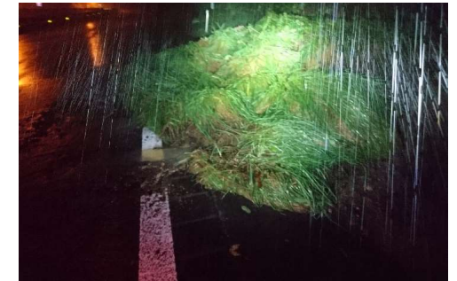
東北道(・山形道): 法面崩落
