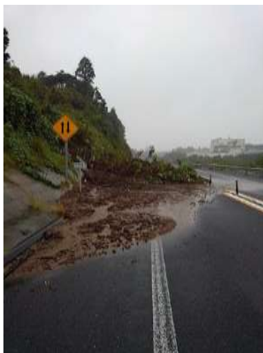
【C4】圏央道 東金 JCT～茂原北 IC 間
