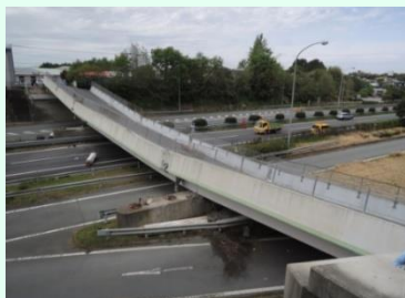
＜ロッキングピア橋の落橋＞
