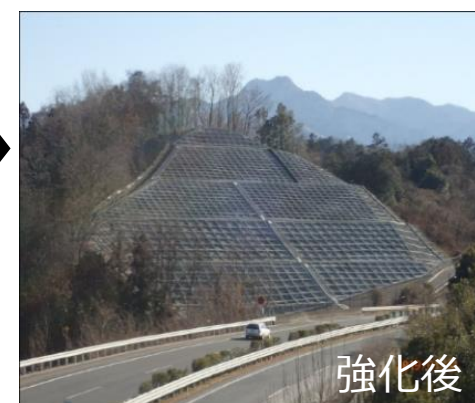
〈上信越道 のり面補強の事例〉
