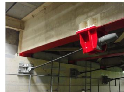
＜対策例2：落橋防止構造＞
