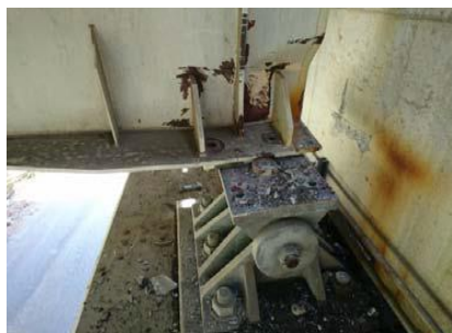
＜熊本地震による支承及び主桁の損傷＞
