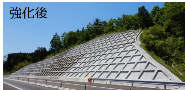
〈常磐道 のり面補強の事例〉
