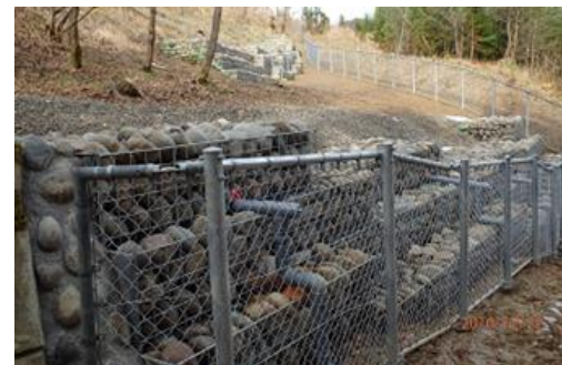
〈盛土のり面補強の事例〉
