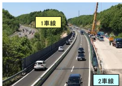
＜ロードジッパーを活用した対面通行規制の状況＞
