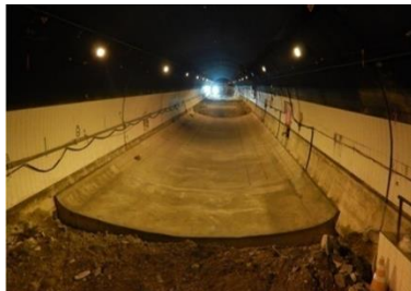
インバート施工例
