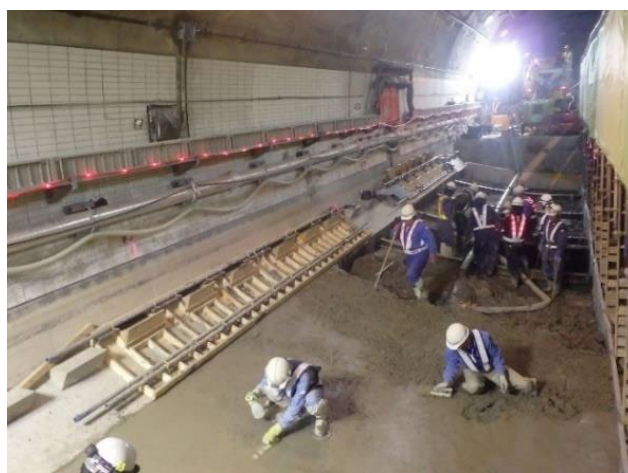
トンネルインバート設置工事
