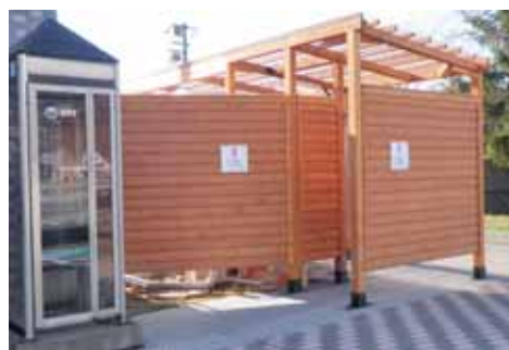
仮設トイレ設置状況
