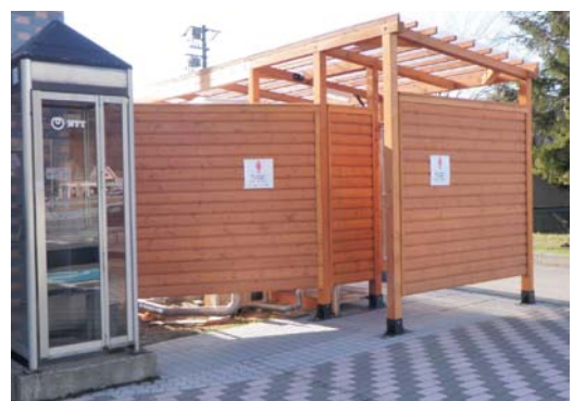
仮設トイレ設置状況
