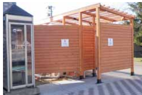
仮設トイレ設置状況
