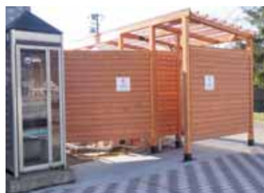
仮設トイレ設置状況
