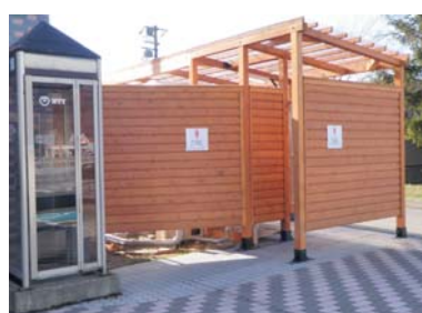
臨時トイレ設置状況
