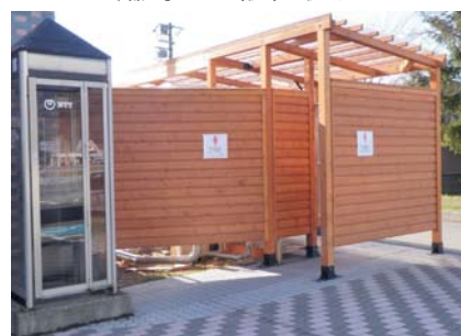
臨時トイレ設置状況
