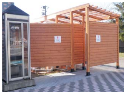
臨時トイレ設置状況
