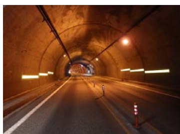
トンネル内における勾配変化の 注意喚起（道東道）
