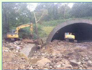
(応急復旧作業中)
