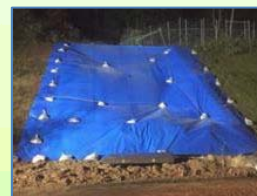
(応急復旧作業完了)
