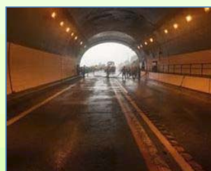
(応急復旧作業完了)
