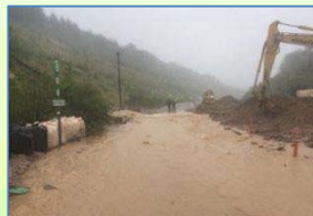
(応急復旧作業中)
