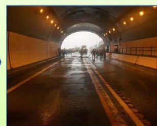
(応急復旧作業完了)
