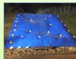
(応急復旧作業完了)
