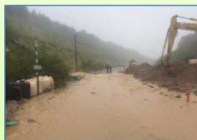
(応急復旧作業中)
