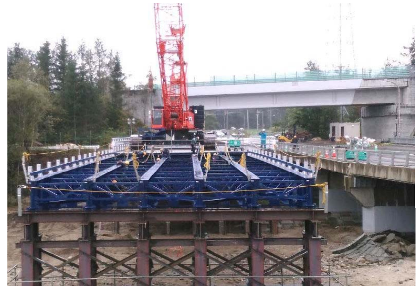
復旧状況【昼間】 ～クレーンによる仮橋設置状況～
