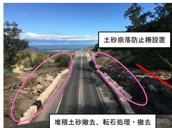
狩勝第二トンネル東坑口（帯広方面を望む）
