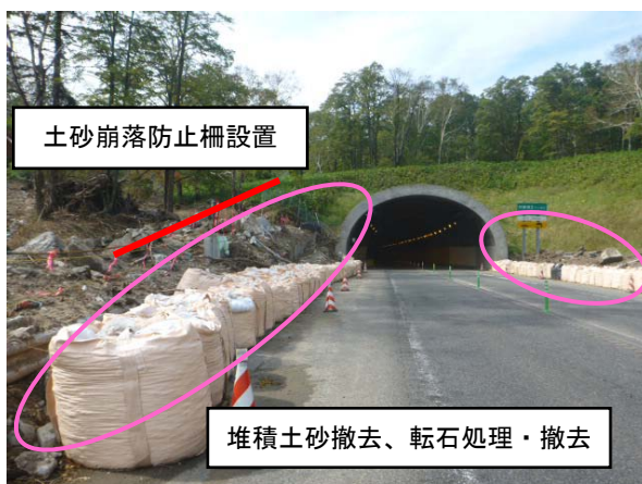
狩勝第二トンネル東坑口（札幌方面を望む）
