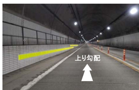
むかわ穂別トンネルの水平ライン
