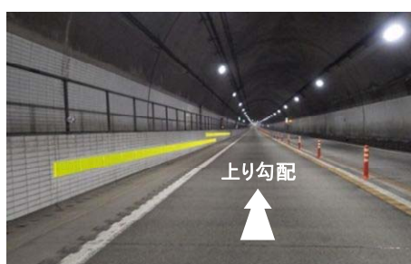
むかわ穂別トンネルの水平ライン
