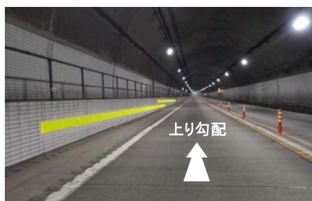
むかわ穂別トンネルの水平ライン
