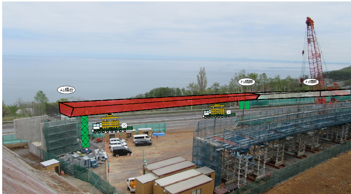
(参考写真)A1 橋台～P1 橋脚間一括架設
