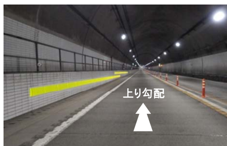
むかわ穂別トンネルの水平ライン
