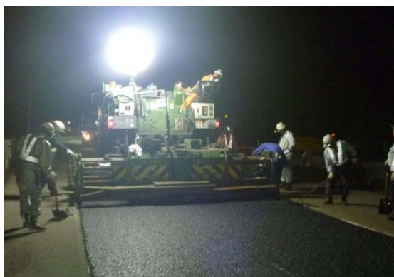
＜路面補修工事＞
